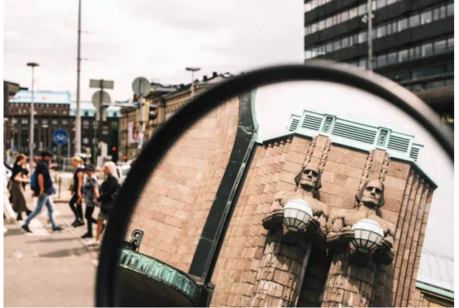
Mit seinen Granitriesen bietet der Kopfbahnhof sowohl innen als auch außen spannende Fotomotive.
