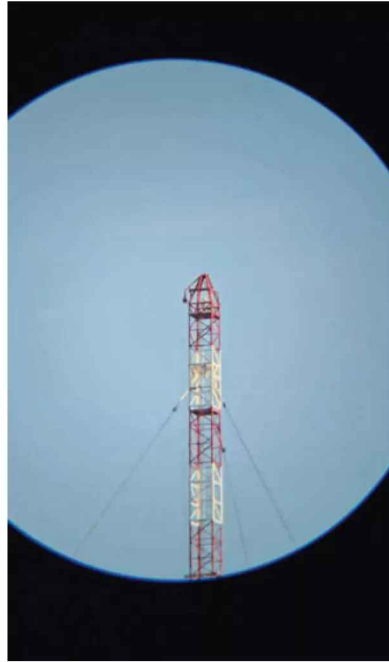
Funkmast aufgenommen mit Normalbrennweite und 50x-Teleobjektiv.
